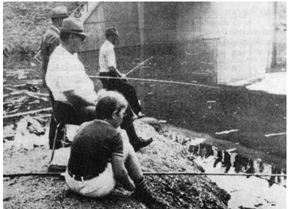
Als Anglerparadies erwies sich der neue „Nordstadthafen“, die Baustelle für die neue Bundesstraße 224 in der Nähe des Moltkeplatzes. Tatsächlich sind im künstlich entstandenen See, der aber mit der Fertigstellung der Bundesstraße wieder verschwand, Fische ausgesetzt worden. Die Wassertiefe betrug etwa 4,00 bis 4,50 m.
