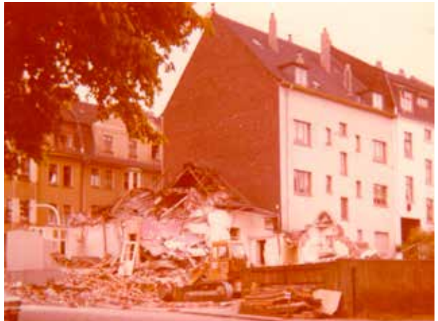
Abriss Haus Ex
